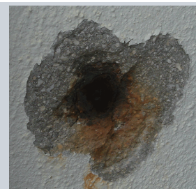
■アンカー切断後のさび
