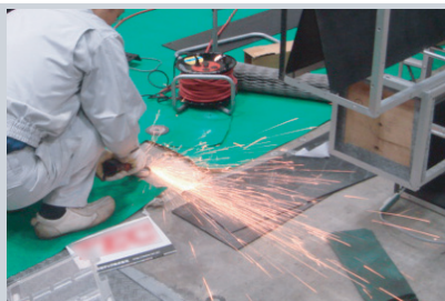
■アンカー切断時の火気管理
