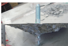
引抜試験破壊形態例 (コーン破壊)
